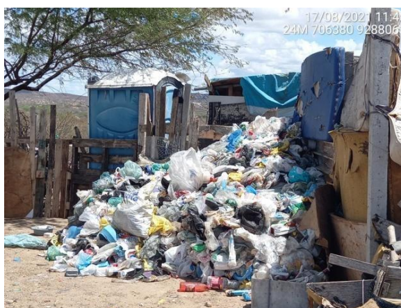
Foto 12. Instalação de banheiros químicos.
