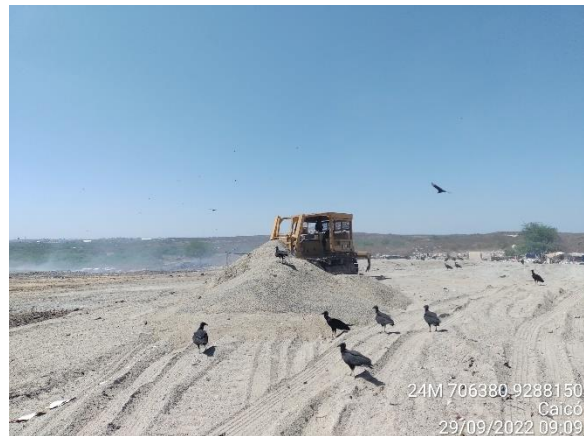
Foto 22. Máquina espalhando o pó de pedra.
